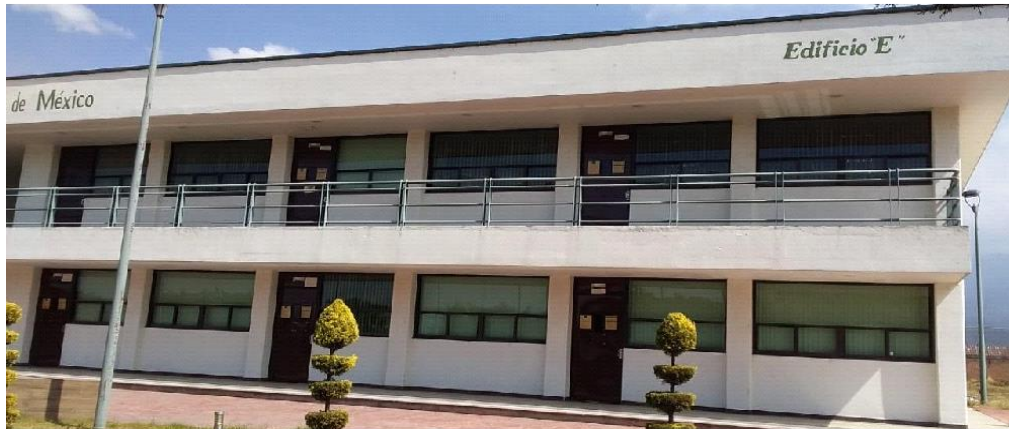
Fotografía No. 25. Colocación de Persianas en el Edificio “E”, del C.U. UAEM Amecameca.
