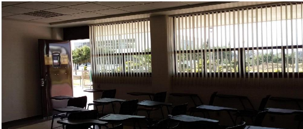
Edificio E, colocación de persianas
