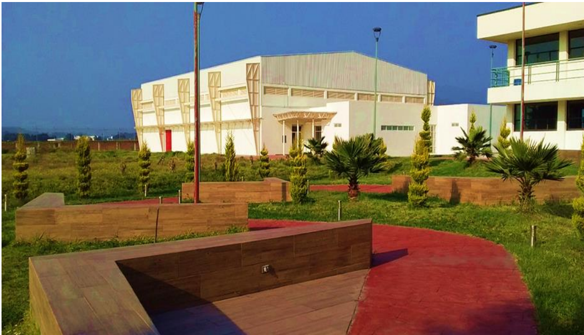
Fotografía No. 23. Gimnasio del Centro Universitario UAEM Amecameca.
